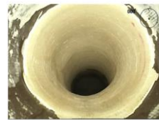
Bild 21 Dicht saniertes Schadensbild (keine Auffälligkeiten)
